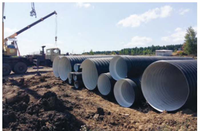
Объект: Технопарк «Отвель», Пензенская область, с. Кижеватово Подрядчик: ООО «РУСКОМПЛЕКТ»
