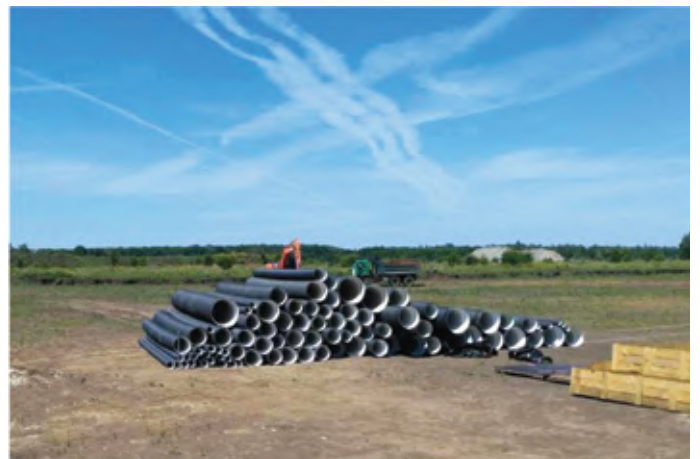
Объект: Логистический комплекс «Спектр», Воронежская область Подрядчик: ООО «Синтез Пайп»
