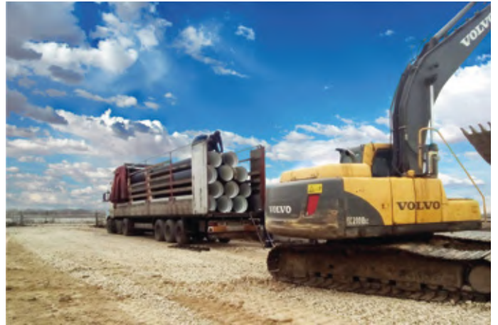
Объект: Прокладка ливневой канализации, Брянская область, г. Унеча Подрядчик: ООО «Фланец-Комплект»
